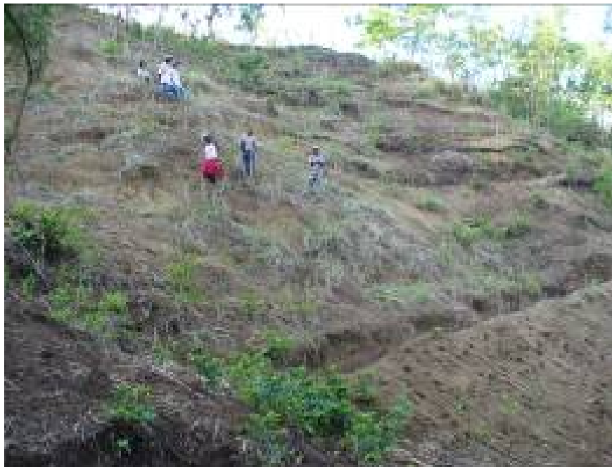
Canaux de contour réalisés au bord de la source à Dabon
