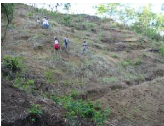
Canaux de contour réalisés à Dabon
